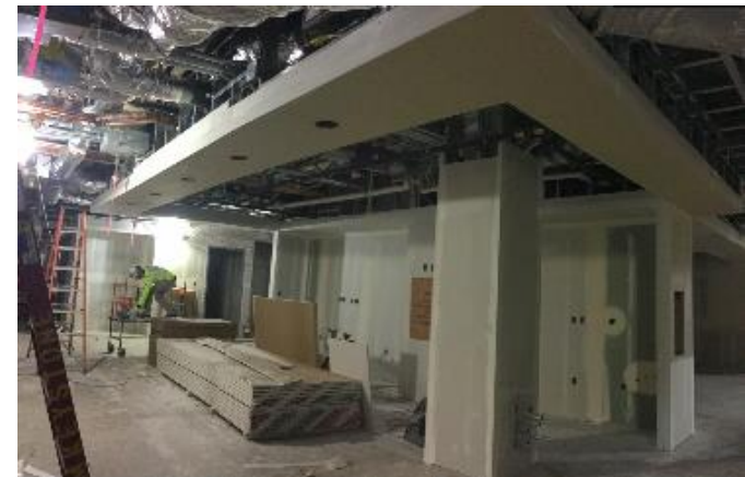
PACU 1 Install Soffit & Drywall
