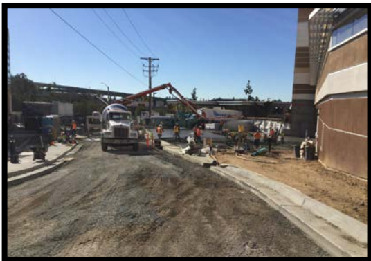
Loading Dock Driveway Pour
