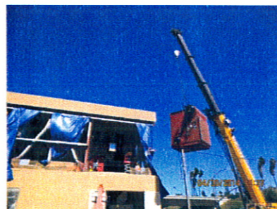
HRSG Installation
