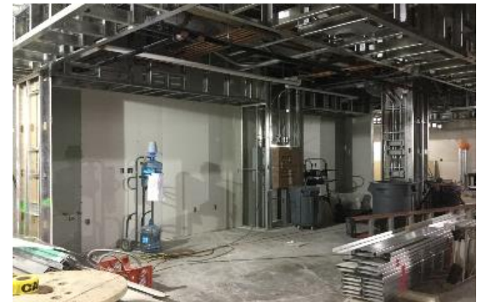
PACU 1 Drywall Installation
