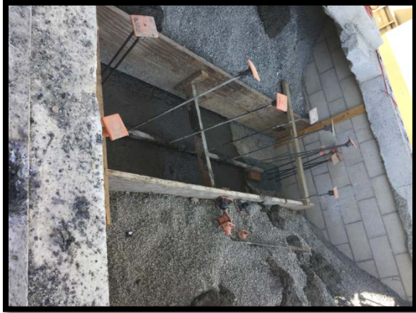
South Loading Dock Footing Pour
