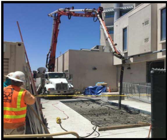
H&V South IAHU2 Concrete Pour
